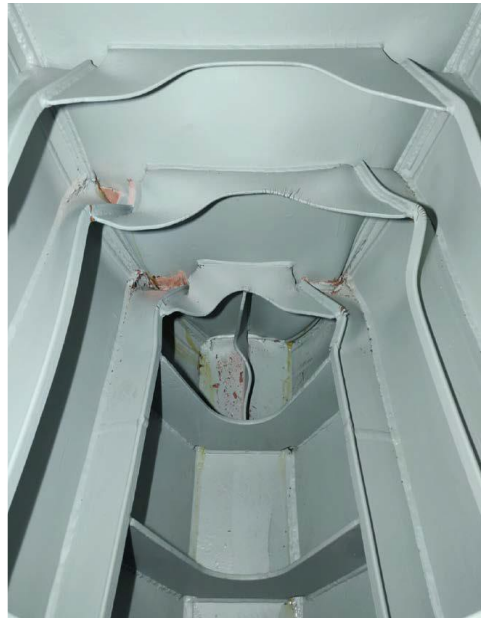
Figure 6 : Après l'échouement, légère entrée d'eau derrière la cloison d'abordage
