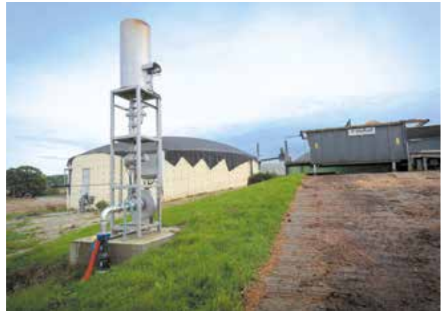
La torchère est mise en fonctionnement pour des raisons de sécurité lorsqu'il faut détruire le biogaz.
