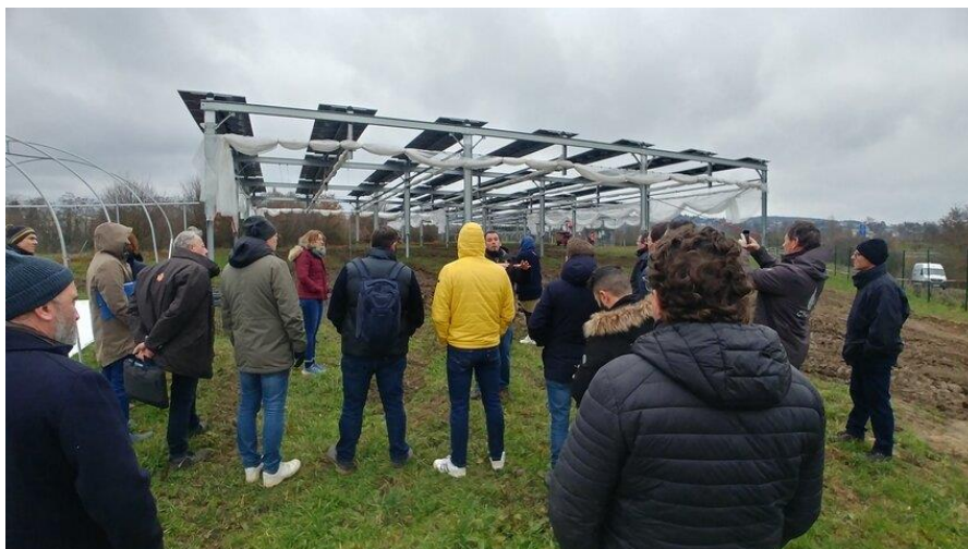
La fin du chantier sur le futur site de production de fraises et framboises sous ombrière photovoltaïque, présentée à des horticulteurs et pépiniéristes locaux.
