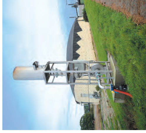
La torche est mise en fonctionnement pour des raisons environnementales et de sécurité lorsqu'il faut détruire le biogaz.
