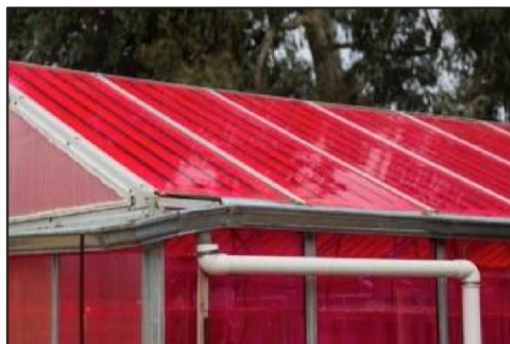
Figure 21: Photo d'une toiture de serre magenta, prototype réalisé par l'Université de Santa Cruz, en Californie (McNulty, 2017)
