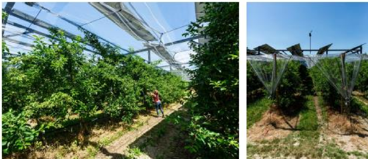
Figure 28: Exemple d'installations photovoltaïques adaptées pour accueillir des filets para-grêles
